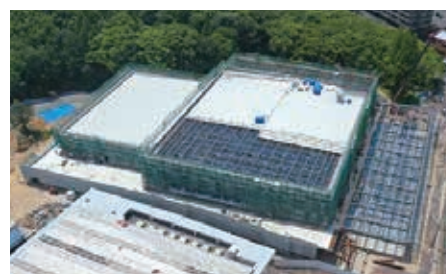
屋根および外壁工事に着手し、一部内装工事が進んでいます
