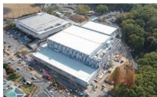
建設中の総合体育館「おおむたアリーナ」
