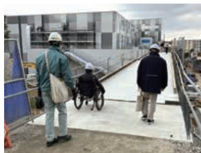
ブリッジの傾斜を確認する職場実習生
