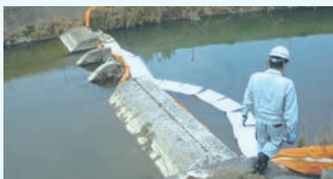
オイルガードで水面に広がった油膜を処理
